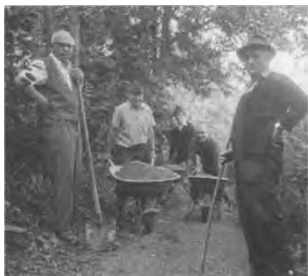
Arbeiten am Heimatpfad „Mauracher Berg“
